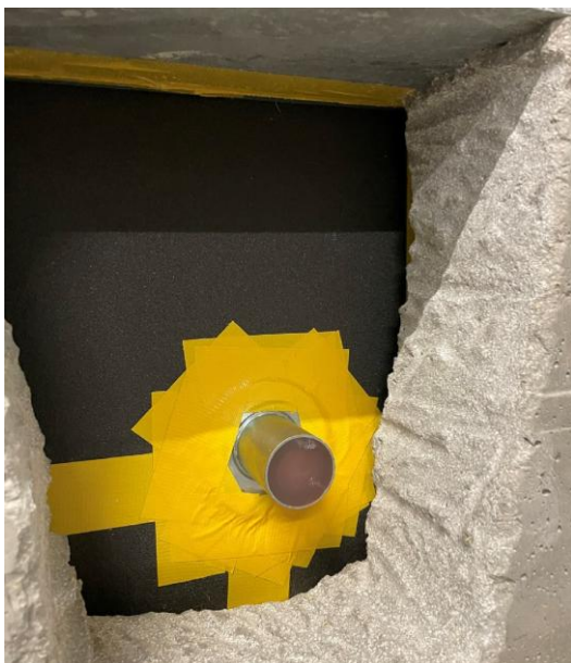
Abbildung 11: ISOBOLT vor Einbau in Wandaussparung
